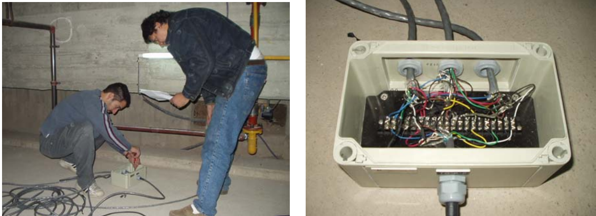
Fig. 9.32: Tendido de cables y conexiones de los sensores externos.
