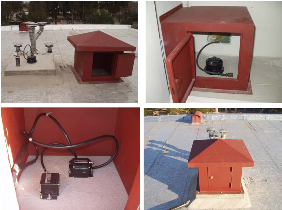
Fig. 9.33: Coberturas metálicas de protección de los sensores (acelerómetros) externos.
