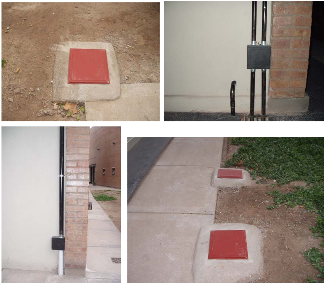
Fig. 9.31: Instalaciones para el tendido e inspección de los cables de los sensores.
